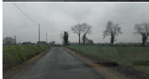
4,7km de curages de fossés
