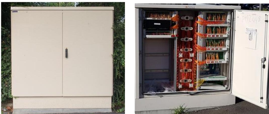
Quand on ouvre une armoire PM, on y trouve 2 parties : En partie gauche arrivent les fibres de chaque opérateur et en partie droite partent les fibres vers chaque PB où seront raccordés les clients.
